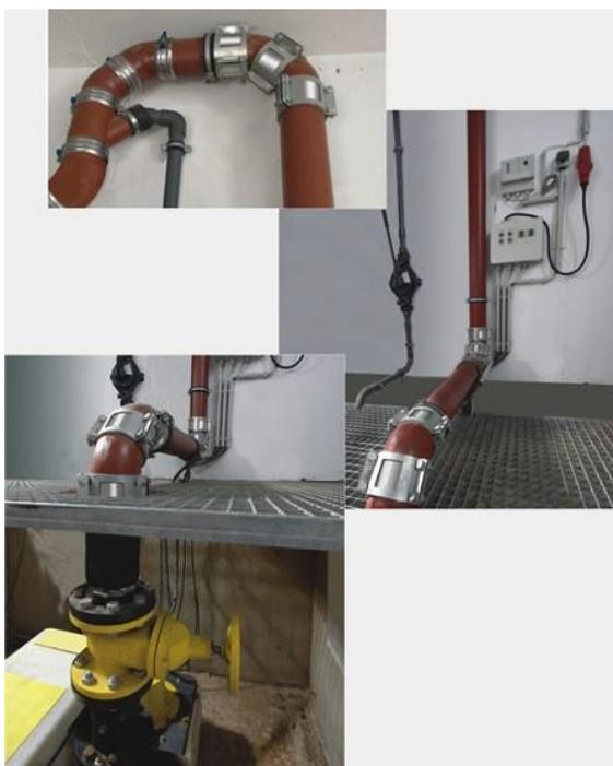
***Fotos: Druckleitung einer Abwasserhebeanlage aus gusseisernen Abflussrohren seit 15 Jahren in Betrieb***
