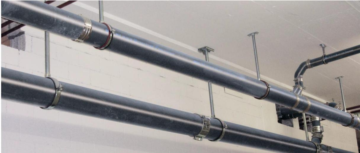
*Gusseiserne Abflussrohrsysteme im Einsatz; MLK-protec Rohr für aggressive Abwässer; (Bild Düker)*
