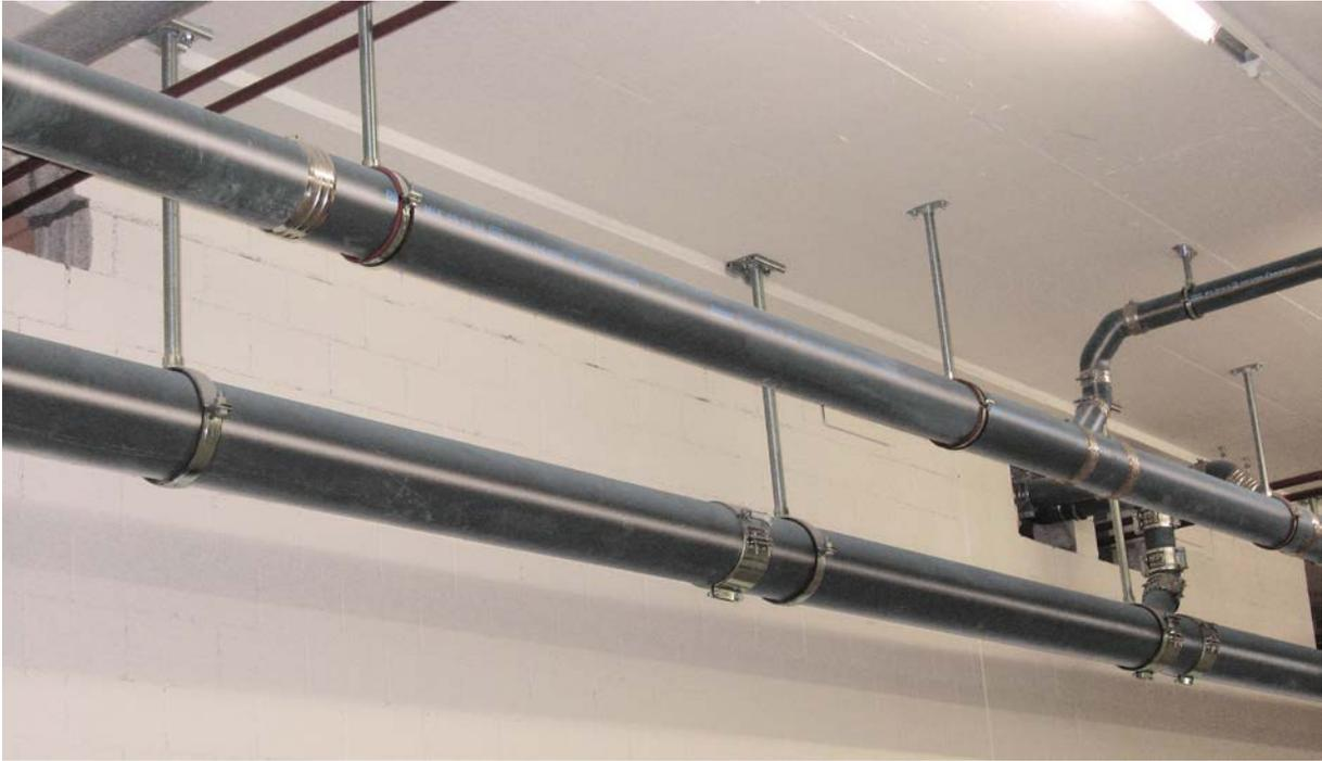
**Foto „Nichtbrennbares gusseisernes Abflusssystem mit Sonderbeschichtung Typ MLK-protec“ (Düker)**
