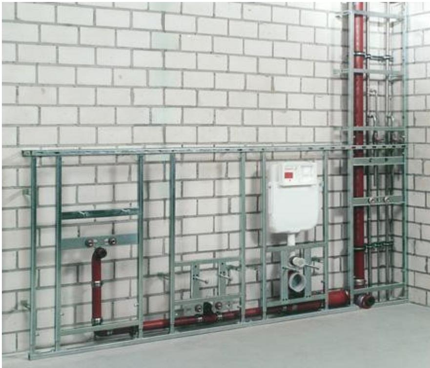
**Bild 2: Komplette Abwasserinstallation aus gusseisernen Abflussrohren (SAINT-GOBAIN HES)**
