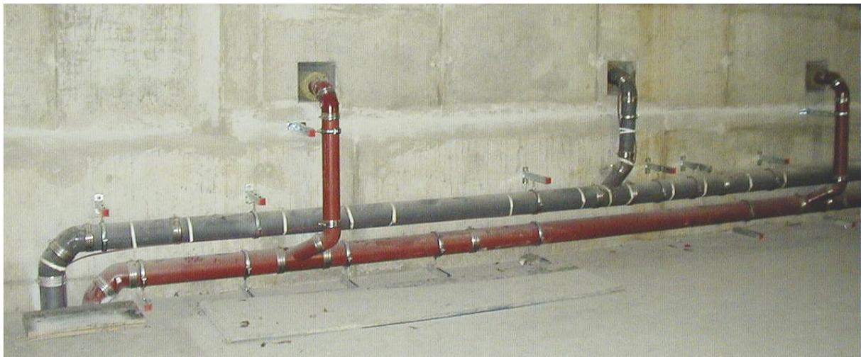
**Gusseiserne Abflussrohrsysteme im Einsatz; oben: KML-Rohr für fetthaltige Abwässer; unten: SML-Rohr für häusliche Abwässer (Bild SAINT-GOBAIN HES)**
