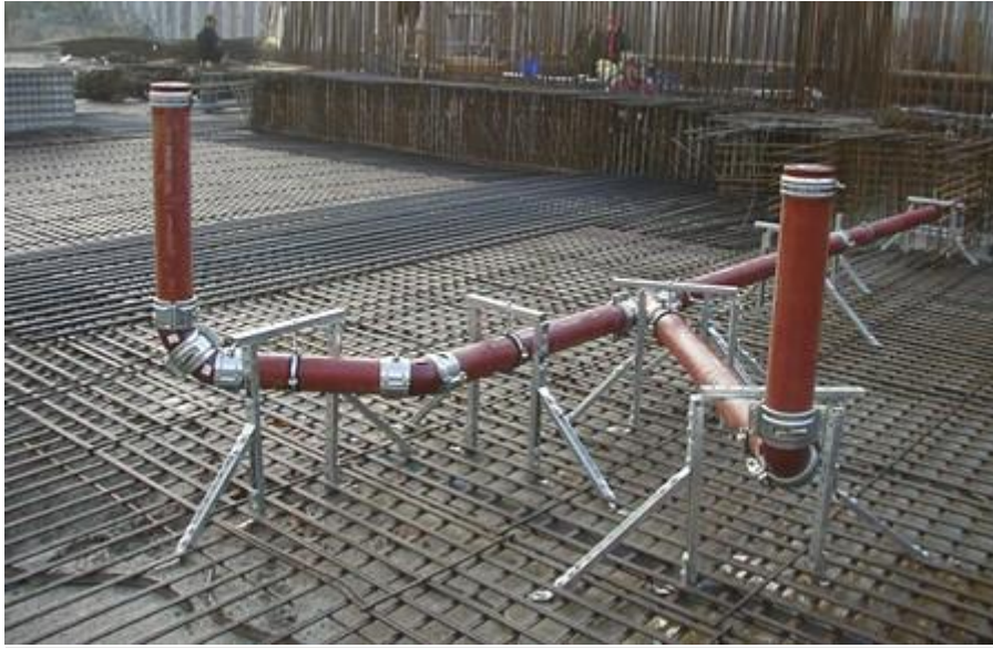
Fotos Einbetonieren von gusseisernen Abflussrohren (SAINT-GOBAIN HES)
