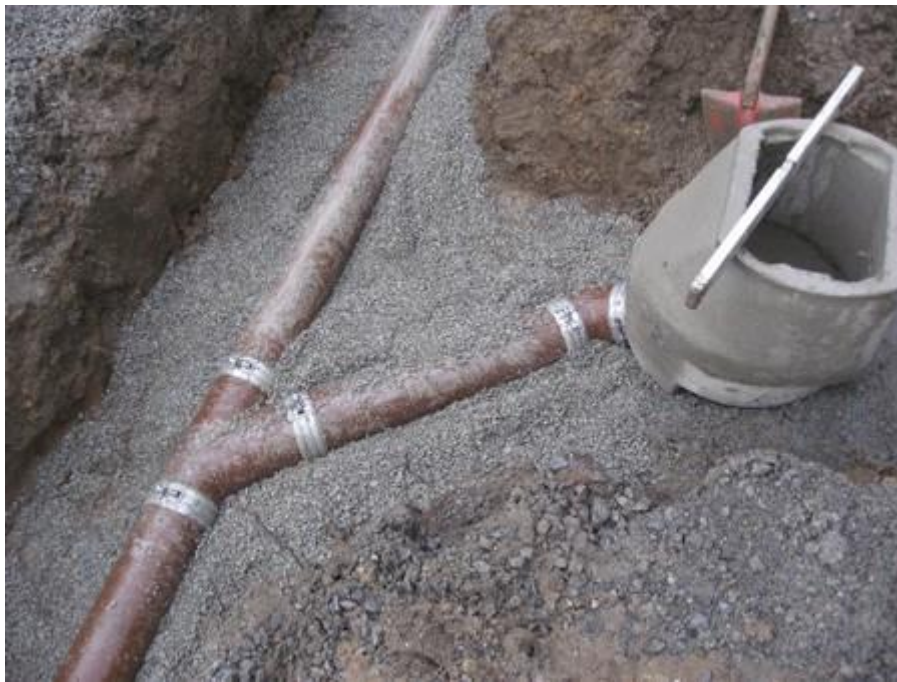
Praxisfotos Verlegung TML-Rohre (Bild DÜKER)
